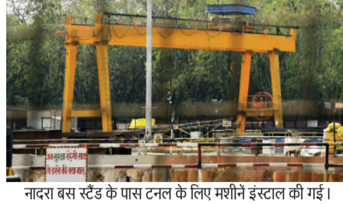
नादरा बस स्टैंड के पास टनल के लिए मशीनें इंस्टाल की गईं।
